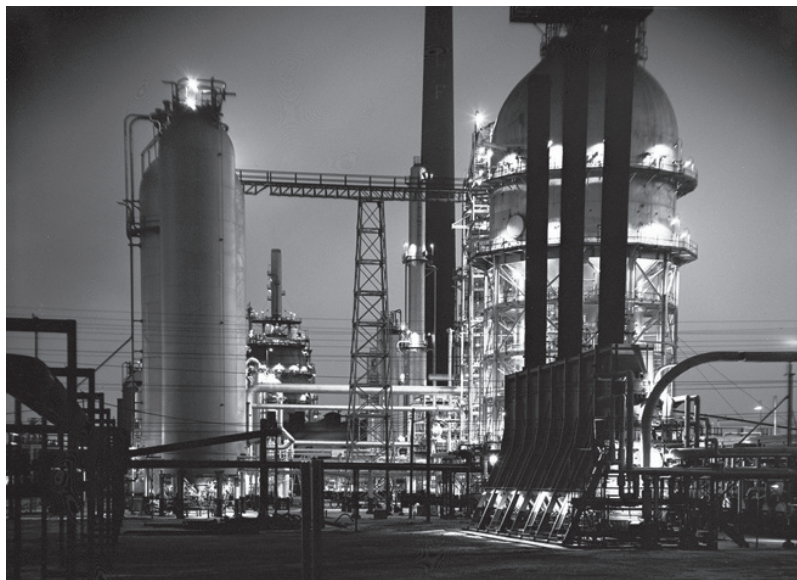
Figura 3.3 | Unidade de craqueamento catalítico fluidizado
