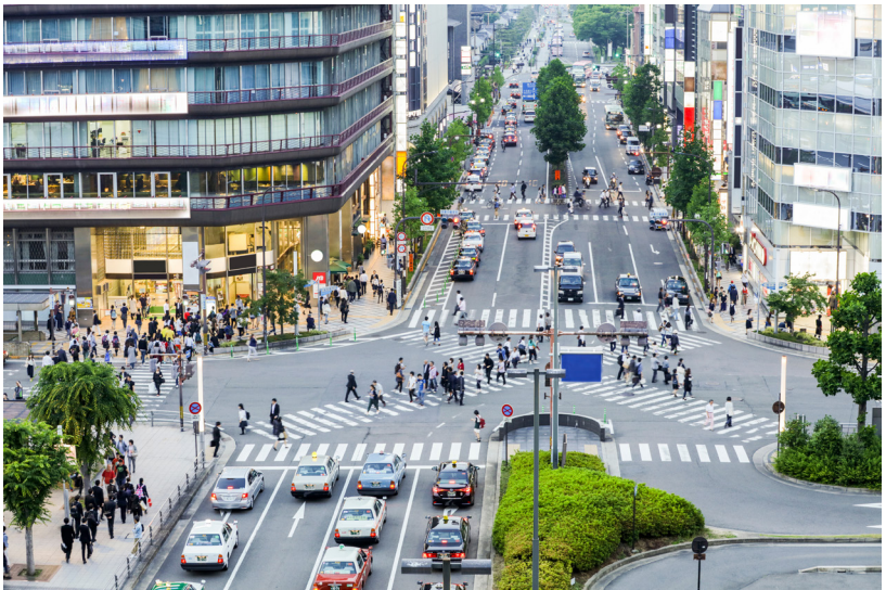
Figura 3.38 | Faixa de pedestre diagonal
