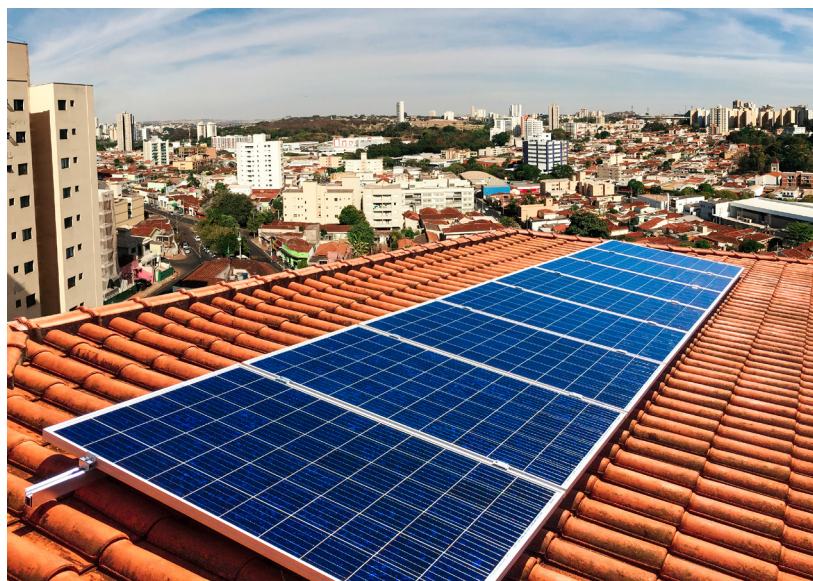
Figura 3.7 | Painéis solares na cobertura de uma residência
