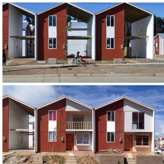
Figura 2.17 | Casas da Villa Verde do escritório Elemental do arquiteto Alejandro Aravena
