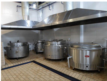
Figura 3.4 | Caldeirão à vapor em UAN
