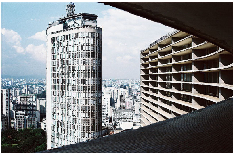
Figura 3.7 | Brises no Edifício Copan
