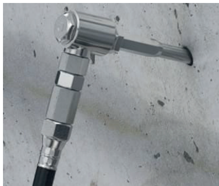
Figura 3.14 | Sistema para injeção de pasta de cimento para tratamento de trinca em concreto
