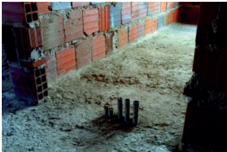
Figura 4.8 | Eletrodutos saindo na soleira da porta
