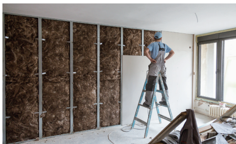
Figura 2.8 | Lã de vidro como preenchimento de paredes
