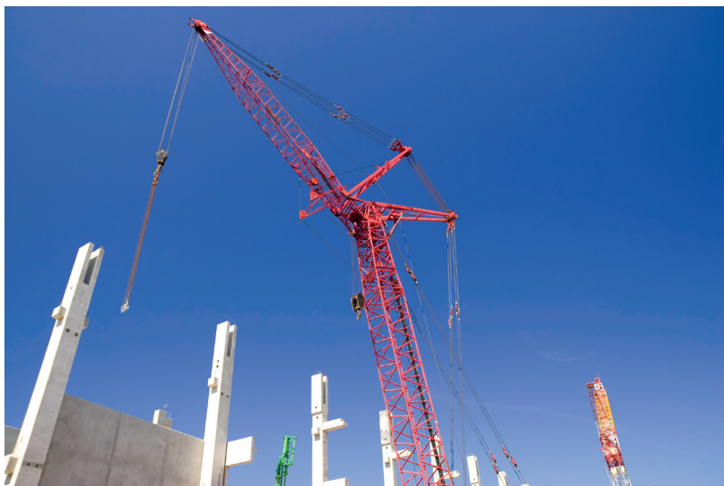
Figura 1.12 | Içamento de pilares e paredes pré-moldadas por meio de grua
