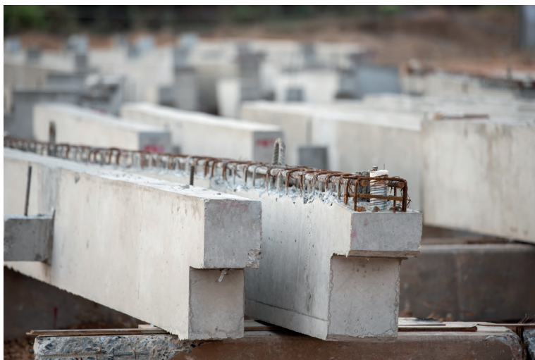
Figura 1.10 | Pré-moldado de seção parcial
