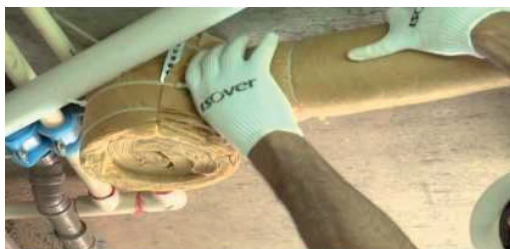
Figura 2.9 | Isolamento de tubulação com calha acústica
