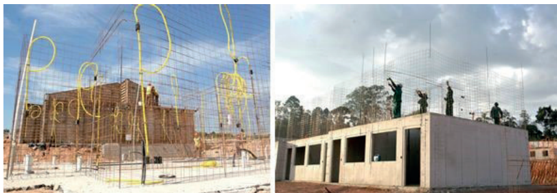
Figura 1.1 | Parede de concreto
