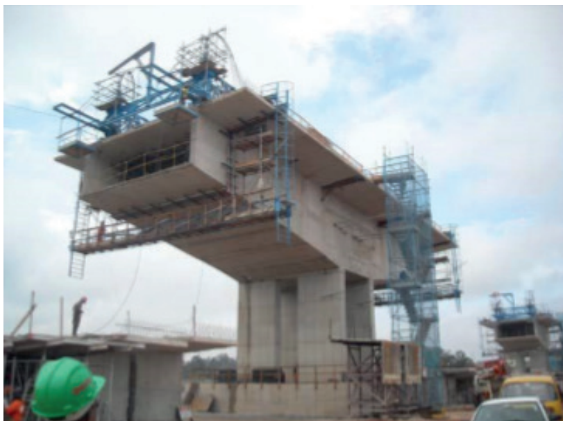
Figura 1.15 | Ponte em montagem por balanços sucessivos
