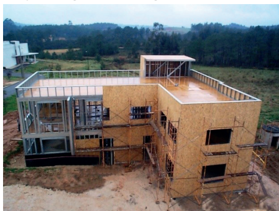
Figura 1.4 | Edificação em Light Steel Framing com fechamento em andamento
