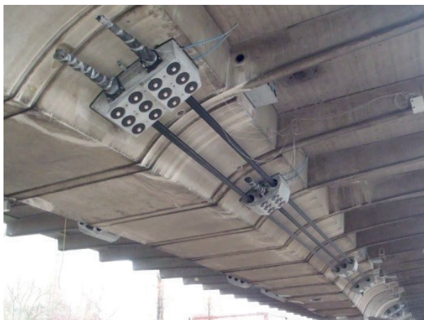
Figura 3.18 | Protensão externa de elemento estrutural
