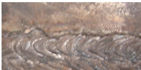
Figura 1.11 | (c) Defeitos em soldas, avaliadas por inspeção visual
