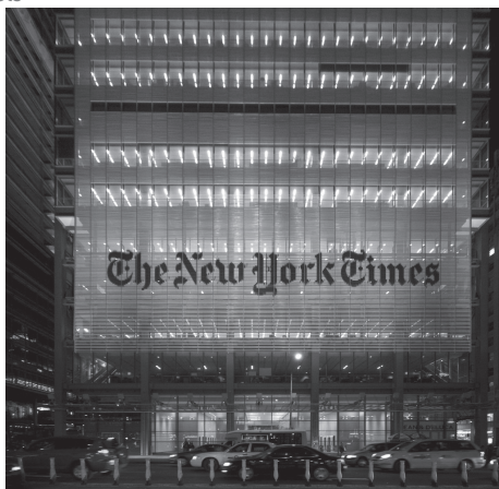
Figura 1.18 | Edifício do New York Times projetado por Renzo Piano e pela FXFOWLE Architects
