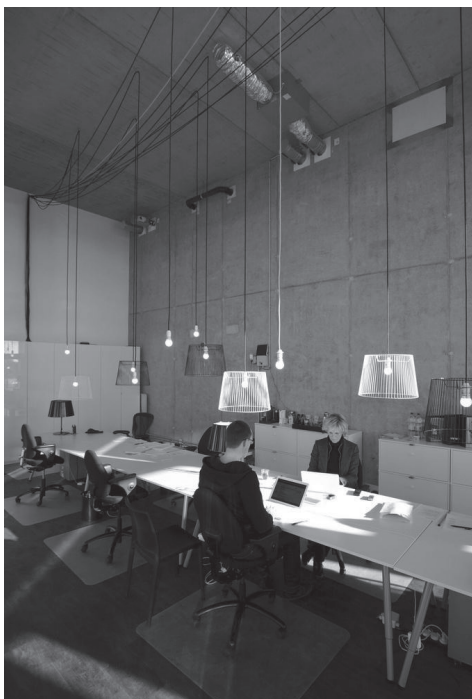
Figura 1.12 | Exemplo de luminárias pendentes em uma sala de projetos
