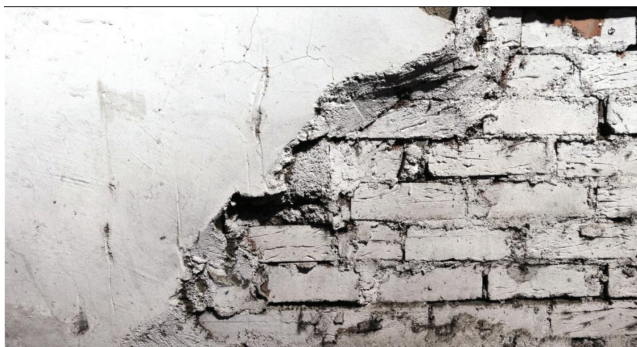
Figura 2.3 | Parede de tijolos
