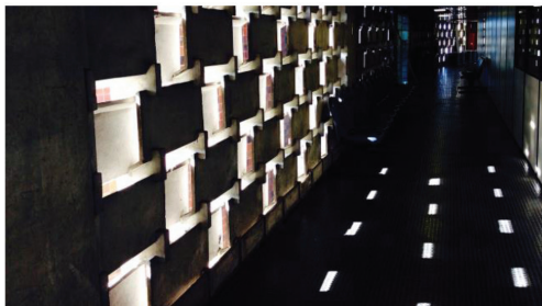
Figura 2.7 | Cobogó no edifício sede da Sudene – Recife, Pernambuco, Brasil
