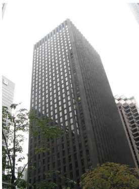
Figura 3.35 | Edifício da CBS, Nova Iorque, arq. Eero Saarinen, 1965
