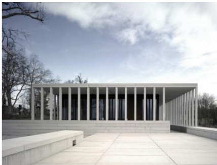
Figura 3.28 | Colunas conformando um plano. Museu de Literatura Moderna, arq. David Chipperfield, 2006
