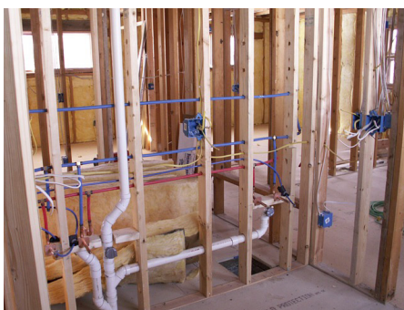
Figura 1.5 | Instalações hidráulicas básicas
