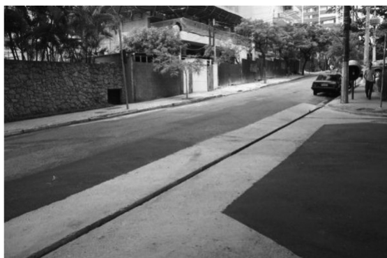
Figura 2.6 | Exemplo de sarjetão no encontro de vias
