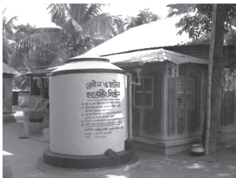
Figura 4.6 | Reservatório utilizado para armazenamento das águas de chuva
