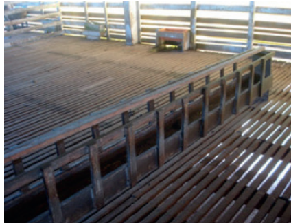
Figura 4.2 | Piso ripado e suspenso para caprinocultura e ovinocultura
